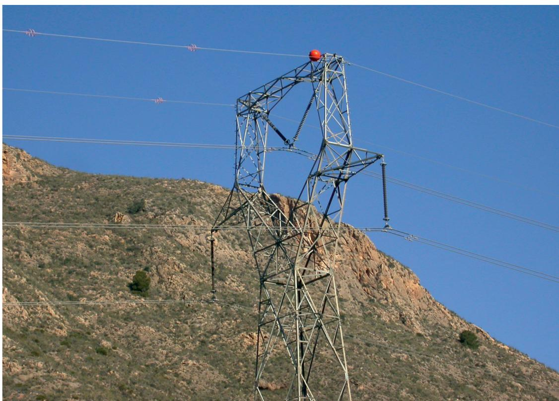
Balizamiento con espirales salvapájaros de una línea de transporte de energía eléctrica en la Sierra de Almenara, realizado en el marco del Proyecto LIFE.
