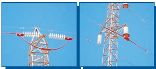
Un kit diseñado especialmente para aislar las zonas de contacto de aves en los apoyos con sistema de amarre o suspensión hacen de él un sencillo sistema de aislar el cable, la grapa y el puente con piezas y otros materiales como el **MLVC** o la cinta **OLIT** hasta 72 KV.
