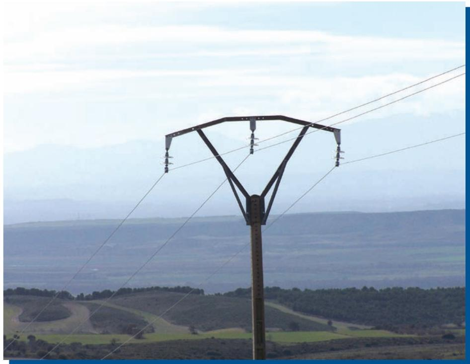
*Los apoyos de alineación se construirán mediante cadenas de aisladores, desechando el uso de aisladores rígidos. Para ello se proyectarán instalaciones con armados en bóveda, pórtico, tresbolillo, etc. que permitan el uso de cadenas de aisladores suspendidas.*
