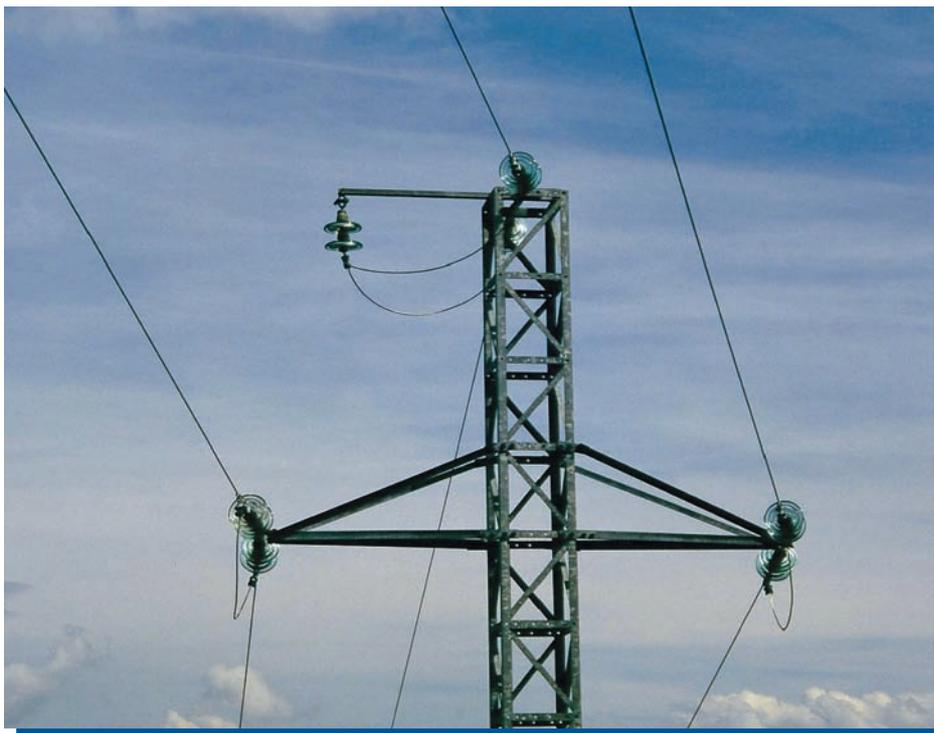
*En apoyos de amarre y alineación con montaje en triángulo deben diseñarse de forma que la distancia entre los puentes flojos o los conductores se mantengan a más de 1.5 m del travesaño inferior.*
