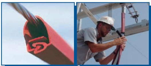
Aunque el diseño del producto esté dirigido a aislar los vanos de cables entre apoyos para evitar disparos de la línea por contactos intermitentes de ramas o entre conductores, hacen de este producto una interesante aplicación en lugares donde es posible tener contactos de aves en los conductores cercanos a la torre.
