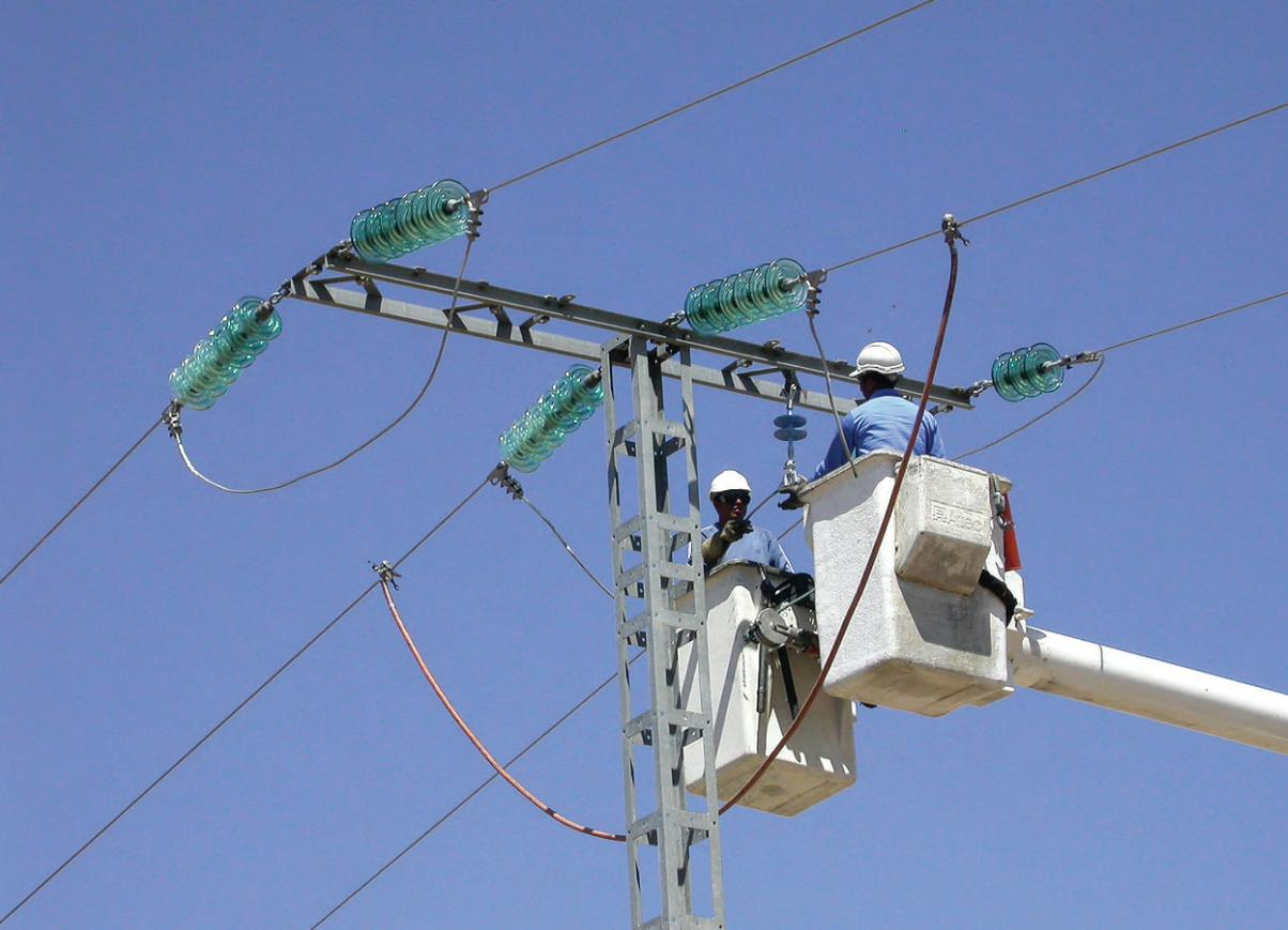
Figura 1.- Operarios realizando la modificación de una línea.
