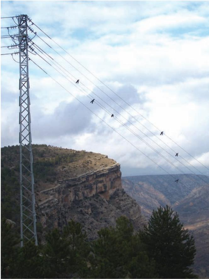
*Señalización de los conductores en un área de interés rupícola. Línea de Aliaga a la C.H. de Pitarque, en la ZEPA de Río Guadalope y Maestrazgo (Teruel). Obsérvese la colocación de las balizas en las tres fases de cada circuito de forma alternativa.*
