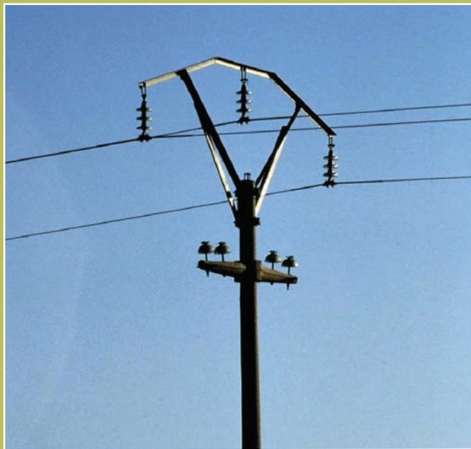
*Cambio de armado en apoyos de alineación para eliminar los aisladores rígidos y poder instalar aisladores suspendidos.*
