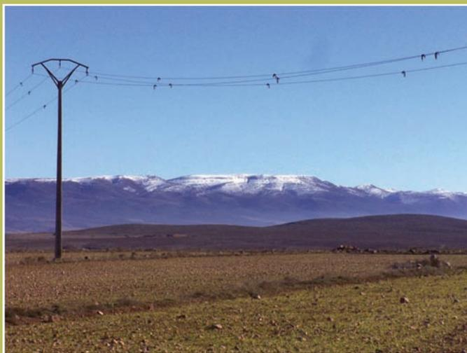
*Tendido de distribución señalizado mediante "X" de neopreno en la ZEPA de Parameras de Campo Visiedo (Teruel).*
