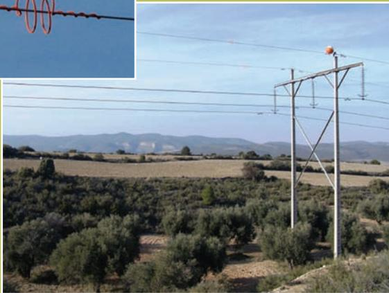
*Señalización de los dos hilos tierra en un área de interés rupícola. Línea de Aliaga a la C.H. de Pitarque, en la ZEPA de Desfiladeros del Río Martín (Teruel). Detalle de la baliza espiral cerrada.*
