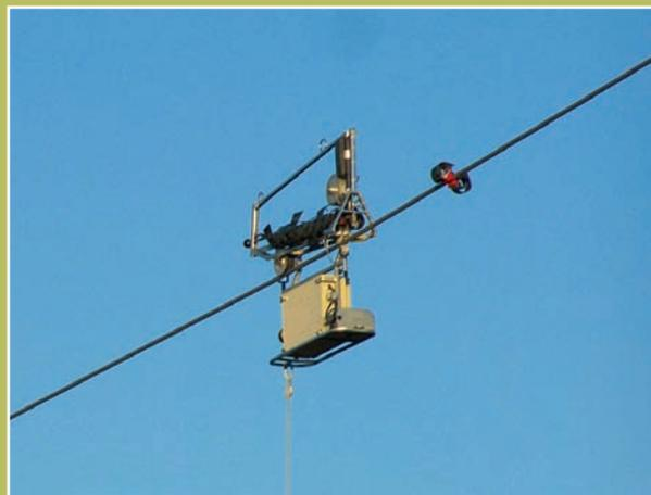
**Las "X" de neopreno tienen la ventaja de poder ser colocadas mediante robot guiado, lo que simplifica las labores de balizamiento.**
