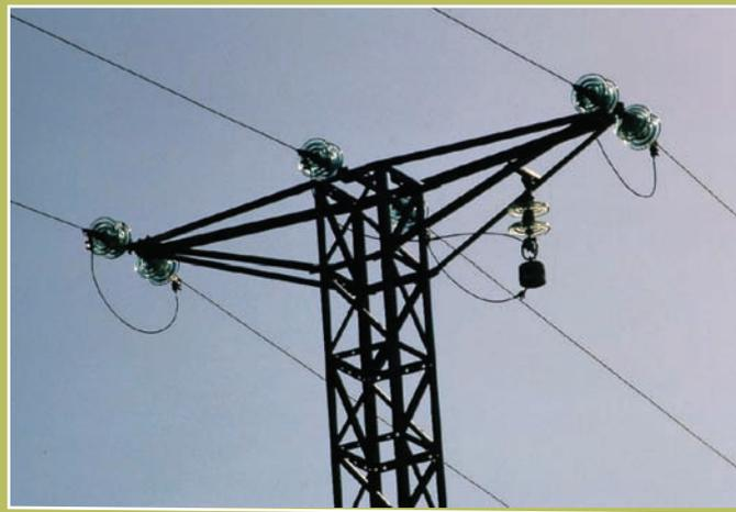
*Reinstalación del puente flojo central suspendido por debajo del travesaño. Obsérvese el contrapeso instalado para evitar que el puente flojo toque la torreta.*
