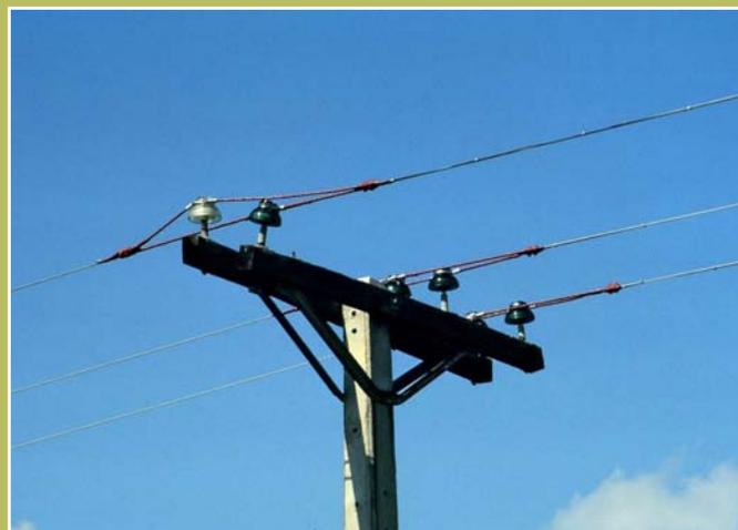
*Aislamiento mediante material termorretráctil Olit de Raychem de 1.5 m de conductor a cada lado de los aisladores rígidos en un apoyo de cruzamiento provisto de doble aislador rígido.*
