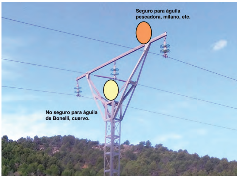
Figura 7.- Diferencia en el comportamiento en la posada del águila de Bonelli que aumenta su vulnerabilidad a la electrocución, por comparación con otras especies de águilas, como el águila pescadora o el águila real o imperial.
