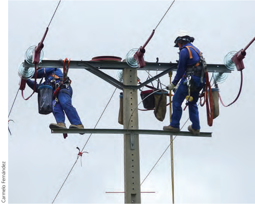
Figura 3.- Aislamiento y salvapájaros en la derivación del Barranco Tropera (Álava) en junio de 2017.
